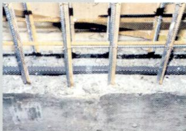
Detalle de colocación
