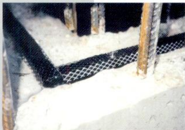
Detalle de unión en ángulo
